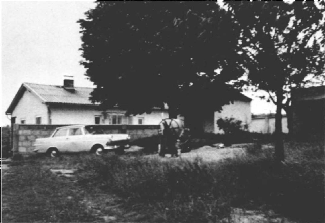
Hinter dem Baum die im 18. Jahrhundert erbaute Rosalienkapelle bei Neudorf (Foto: K. Donat 1970)
